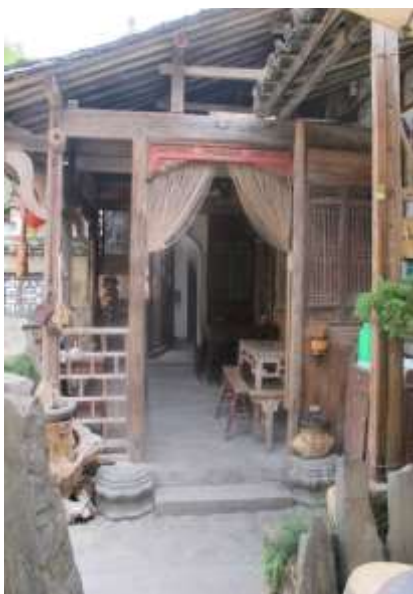
2-9 上水圳松鹤堂客栈新建门口 （延伸至路边）
