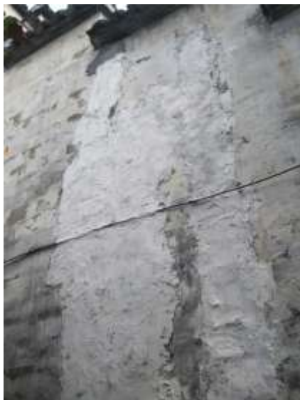
图 2-4 月沼东北角一民居墙体修缮
