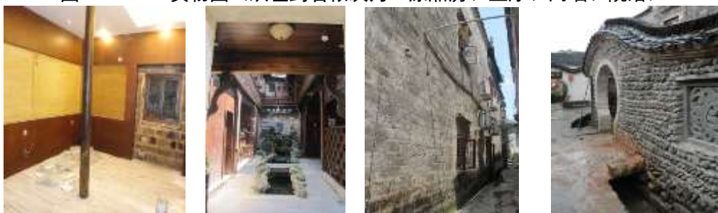
图 2-21 W09 实物图（从左到右依次为：原厢房、主厅、门墙、院落）
